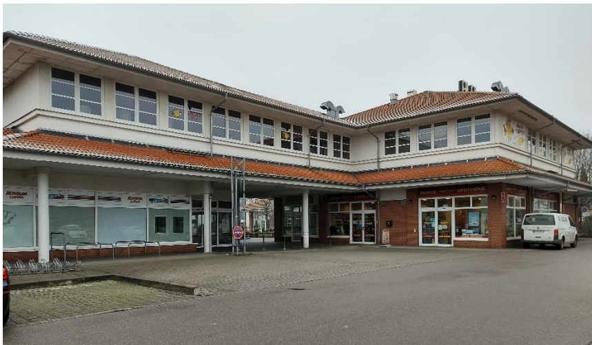
Foto 4: Aktuelle Gewerbeimmobilie mit Leerständen
