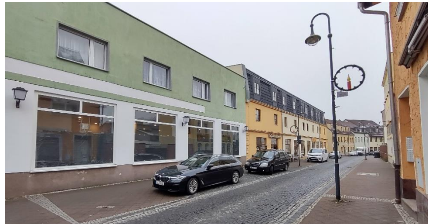
Foto 8: Betriebe in Erdgeschosslage an der Leipziger Straße / Leerstände
