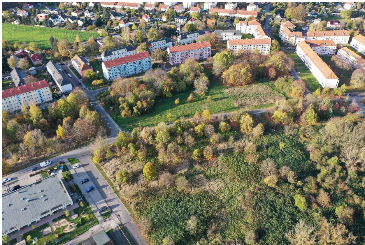
Abbildung 7: Blick Richtung Nordwesten zur Thomas-Mann-Straße, links im Vordergrund die Kita „Grashüpfer“ (08.11.2022).
