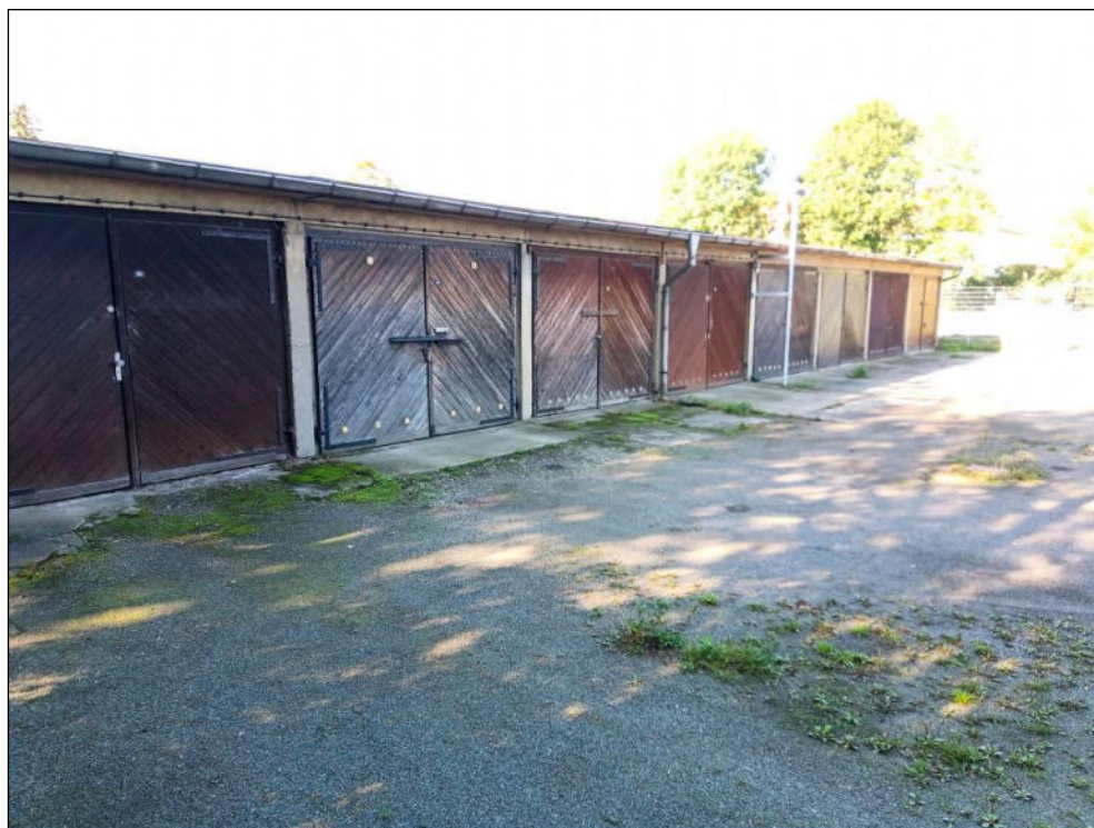
Bild 4: Garagenkomplex im Südosten des Plangebietes. (21.09.2022)
