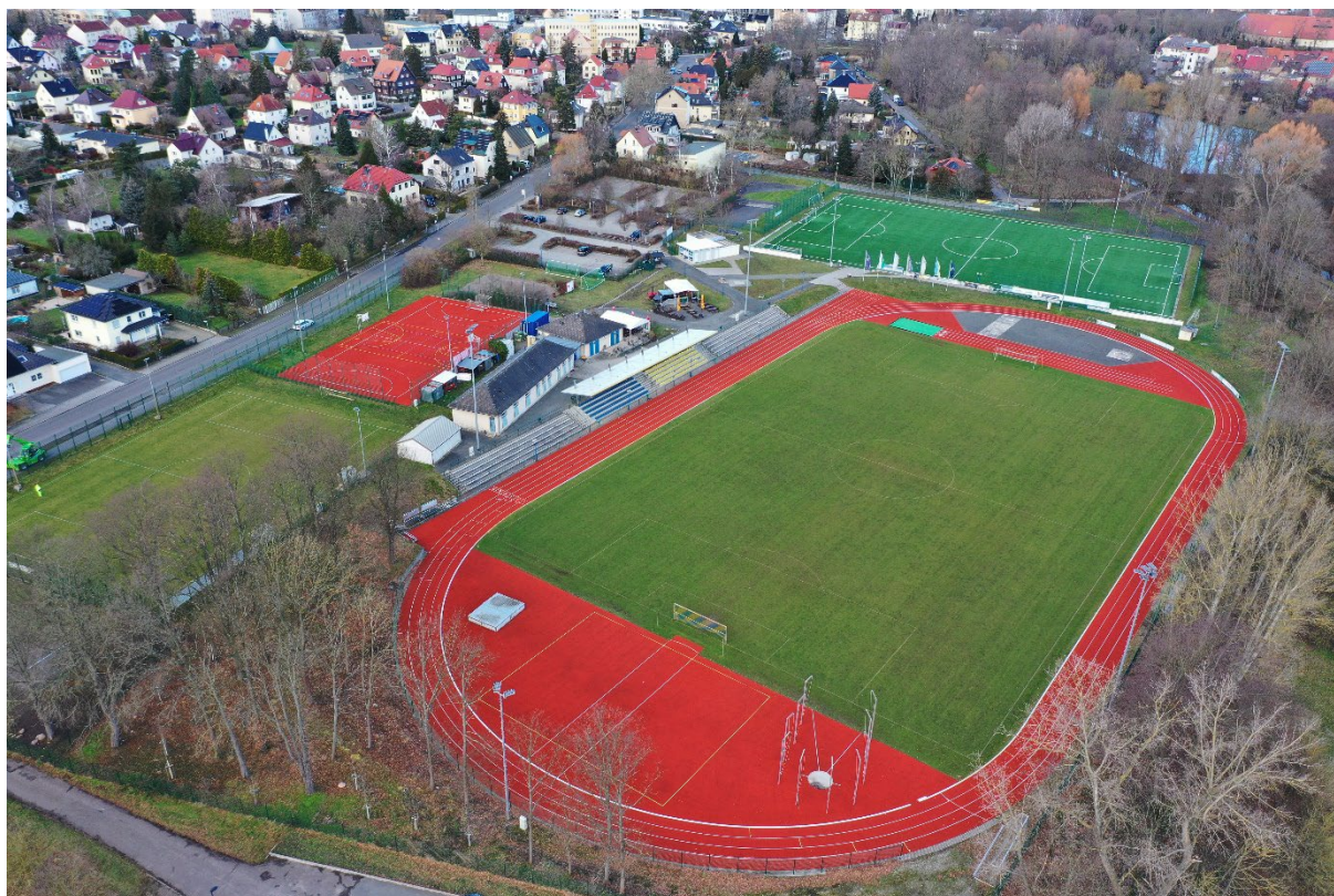
Abbildung 2: Blick auf das SFZ mit Rasengroßspielfeld und Leichtathletikanlagen, Kunstrasenplatz im Hintergrund, Tribüne und Funktionsgebäude in Bildmitte und Kleinsportfeldern links im Bilde an der Kriekauer Straße (08.01.2025).
