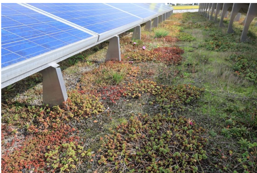
Abbildung 35: Gründach in der Biocity Leipzig, in Kombination mit Photovoltaik-Anlage (08.10.2021).
