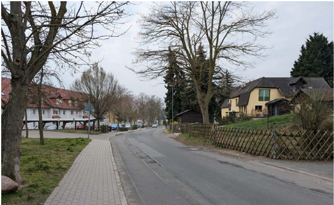
Foto: Merkwitz, sanierungsbedürftige Alte Salzstraße (IVAS 03/ 2025)
