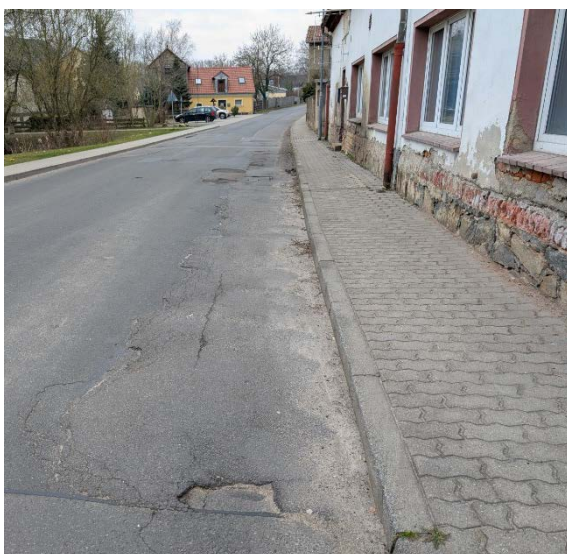
Foto: Seegeritz, Hauptstraße, vor und nach der Sanierung
